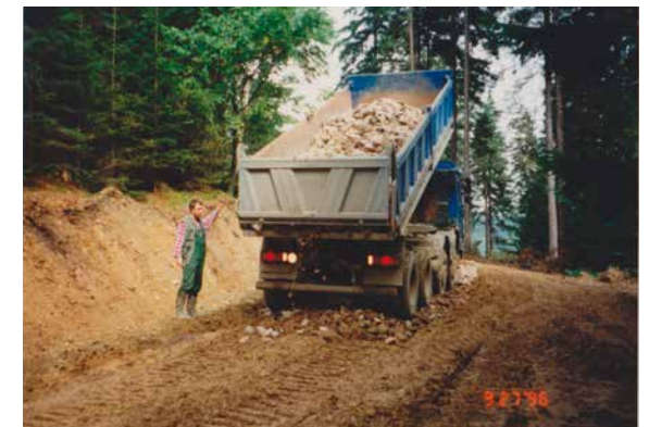
Abb. 41: Neubau von Abfuhrwegen am Schönfelder Hang, 1997 (Quelle: Bildarchiv Forstbezirk Bärenfels)
